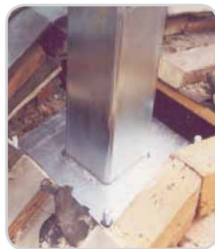
Installazione paletto su trave di colmo
